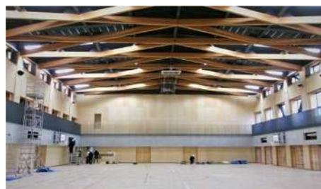
【国産木材等を使用した体育館】
