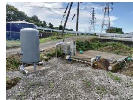
改修工事（井戸ポンプ）
