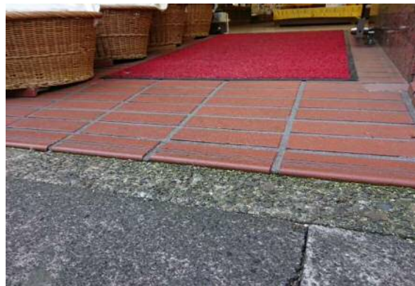
店舗入り口： 扉は開き戸(両開き)、段差が1段有り
