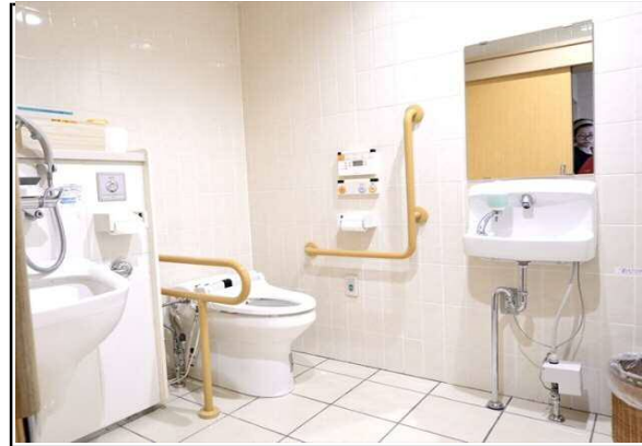
車いす対応トイレあり：引き戸(幅82.5cm) 手すり(壁側：L字型 移動側：T字型)
