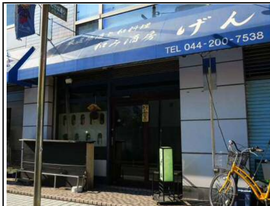
建物の入り口に、縁石を含む段差が2段
