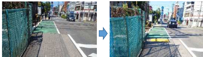
踏切手前部への点字シート設置（中野島・稲田堤駅周辺地区）
