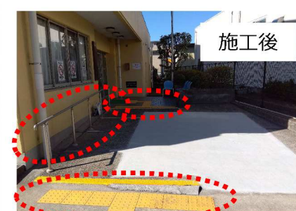
傾斜路手すり・点状ブロック新設（下平間老人いこいの家）
