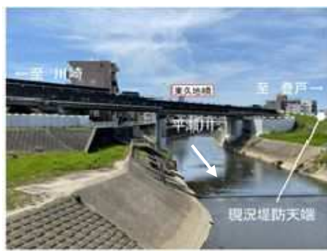
平瀬川との合流部（東久地橋付近）
