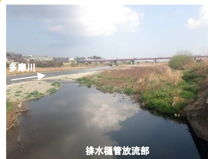
排水樋管放流部
