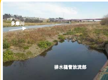
排水樋管放流部
