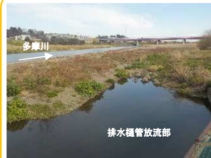
排水樋管放流部
