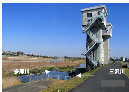
三沢川との合流部
