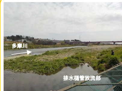
排水樋管放流部
