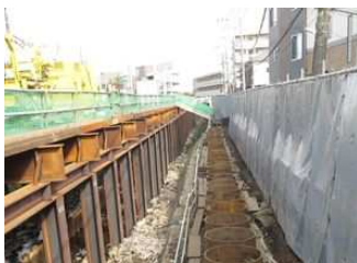
鋼管杭の打設
