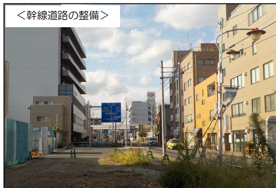
一般国道 409 号（小杉）【整備前】
