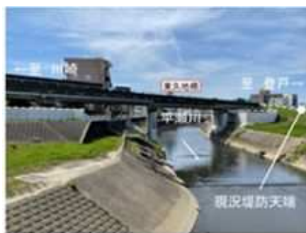
平瀬川との合流部 (東久地橋付近)
