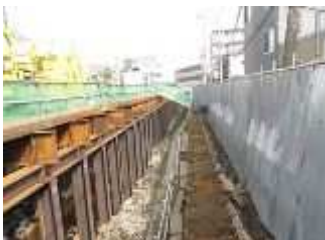
鋼管杭の打設
