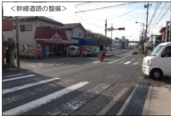
世田谷町田線（片平）【整備前】
