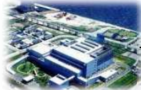
浮島処理センター
