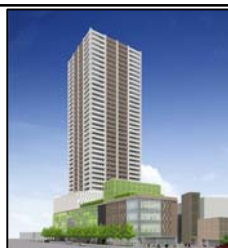
武蔵小杉南口地区西街区
