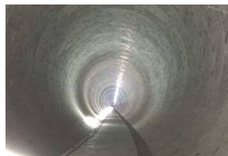
トンネル部状況
