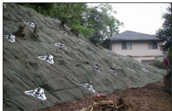
緑地保全と斜面安定の両立 (ノンフレーム工法)
