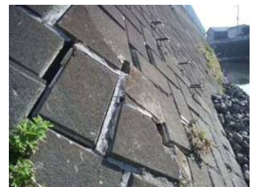
護岸の変状 (ブロック隙間の拡大)
