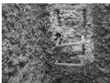
硫化水素による槽内部の劣化
