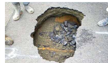
下水管きょの老朽化に起因する道路陥没
