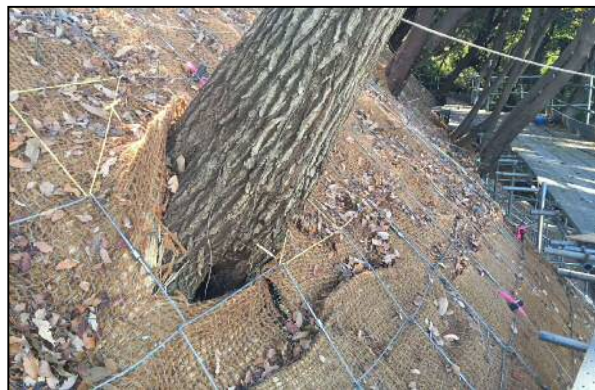
緑地保全と斜面安定の両立
