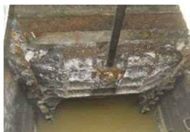
硫化水素による槽内部の劣化
