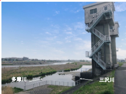
三沢川との合流部
