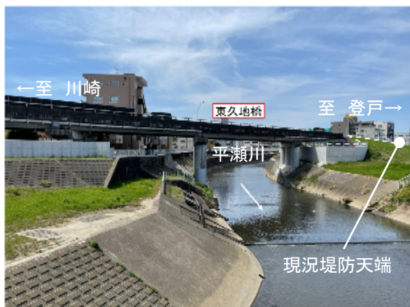
平瀬川との合流部（東久地橋付近）
