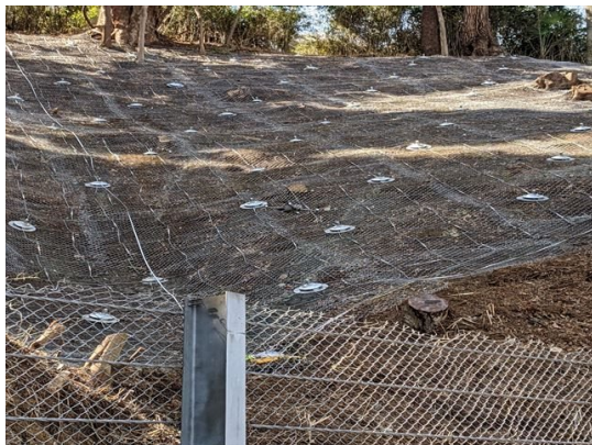
斜面安定整備工事 (長尾特別緑地保全地区)
