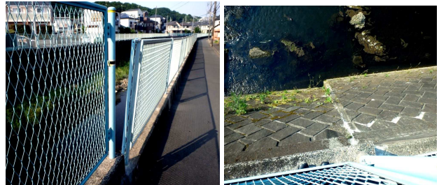
変状による護岸施設の目違い
