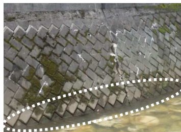
護岸の変状(ブロック隙間の拡大)
