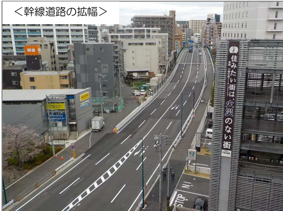
東京丸子横浜線 【4車線供用開始】 (令和4年3月)
