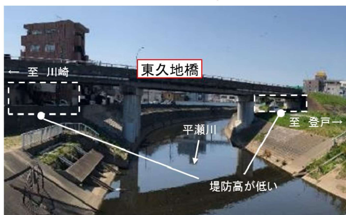
平瀬川との合流部（東久地橋付近）
