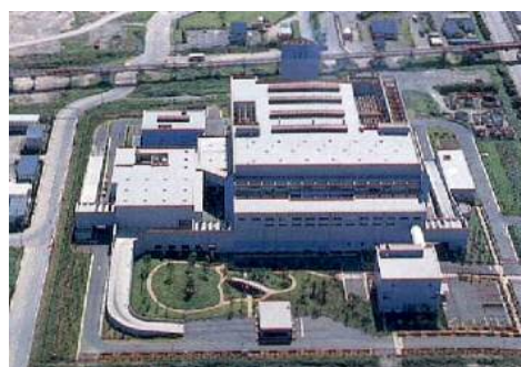
《 完成時 (H7 年) の浮島処理センター 》
