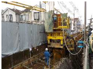
鋼管杭の打設
