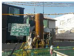
鋼管杭の打設
