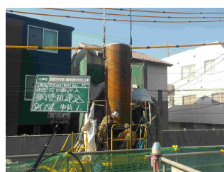
鋼管杭の打設
