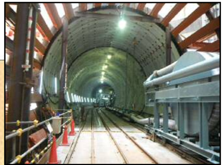
初期掘進状況(分流部立坑)
