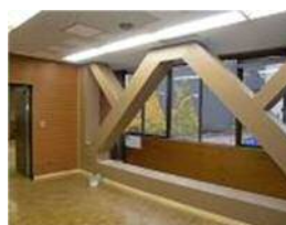
特定建築物 鉄骨ブレース施工
