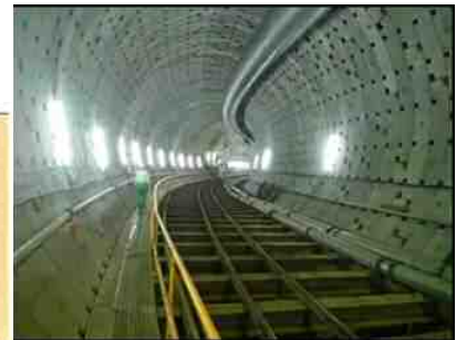
シールドトンネル掘進状況
