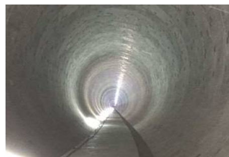
トンネル部状況
