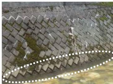
護岸の変状(ブロック隙間の拡大)
