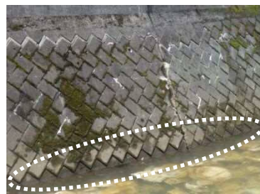
護岸の変状(ブロック隙間の拡大)
