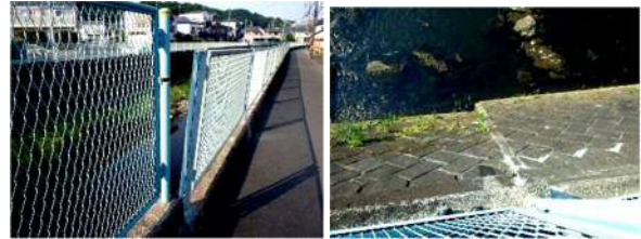
変状による護岸施設の目違い
