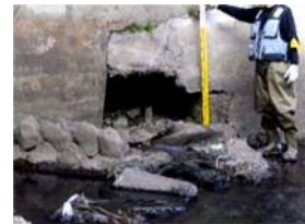
護岸背面部の空洞
