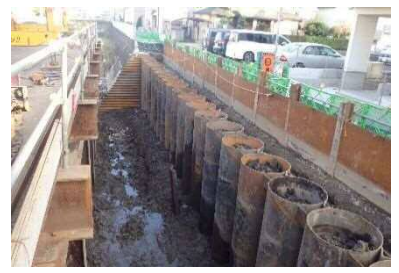
鋼管護岸へ更新中 【市費にて対応】
