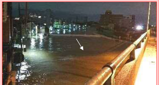
平瀬川周辺（多摩川との合流部）の浸水状況
