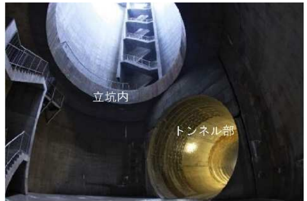
立坑内トンネル
