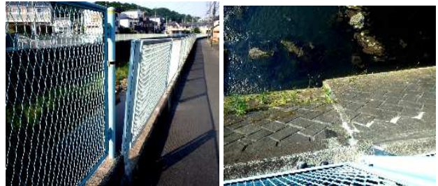
変状による護岸の目違い
