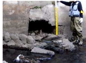
護岸背面部の空洞
