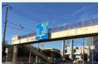
旭町二丁目歩道橋
