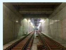
地下トンネル
