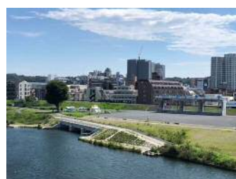
五反田川放水路整備事業
