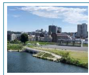
五反田川放水路整備事業
