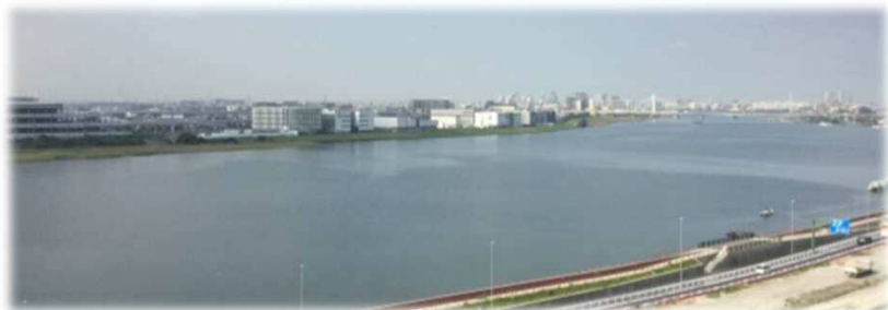
工事前の写真
