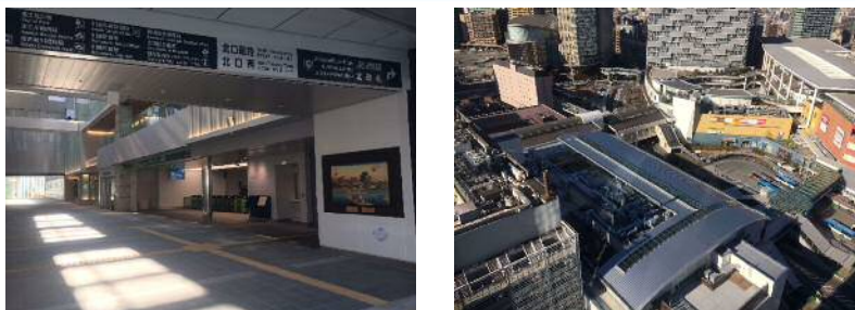
川崎駅北口自由通路・北改札供用開始 (H30.2.17供用開始)
