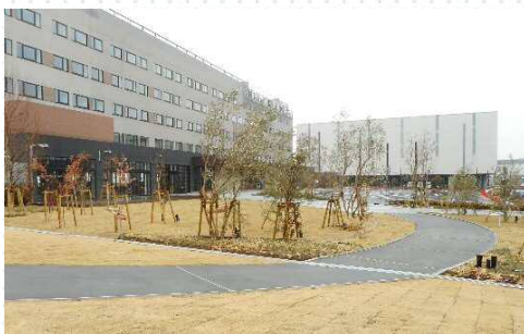
一体化整備完成箇所
