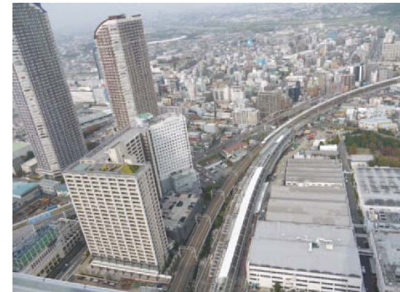
小杉駅周辺地区再開発等事業 JR横須賀線武蔵小杉駅 平成22年3月13日開業
