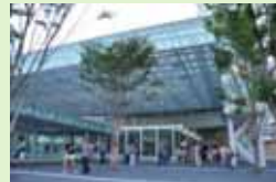
川崎駅東口駅前広場再編整備H23.3.26完成
