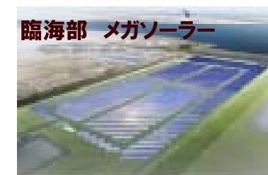
国内最大級の太陽光発電所 発電量 約2万kW 設置面積 約30ha 平成23年度 運転開始予定
