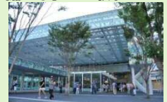
川崎駅東口駅前広場再編整備 H23.3.26完成
