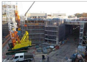
▲ミックスペーパー資源化処理等の建設工事写真
