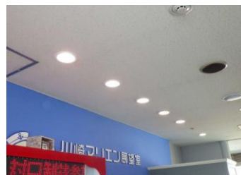
▲川崎マリエン展望室 LED設置後
