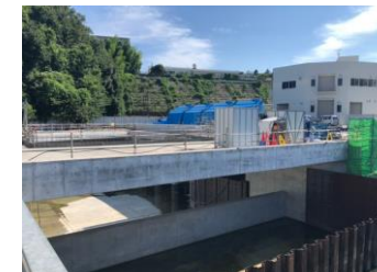
▲建設工事写真(分流部)
