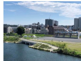
▲建設工事写真(放流部)
