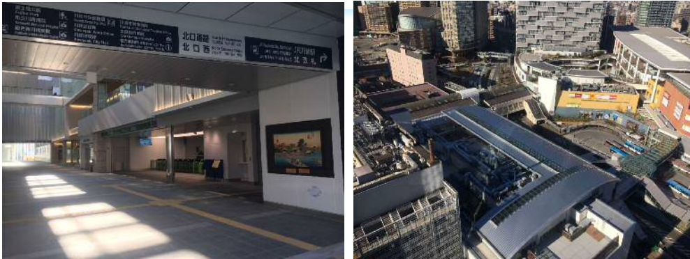
川崎駅北口通路・北改札供用開始（H30.2.17供用開始）
