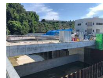
▲建設工事写真（分流部）
