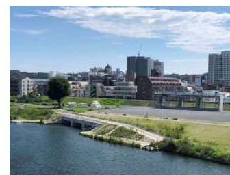
▲建設工事写真（放流部）
