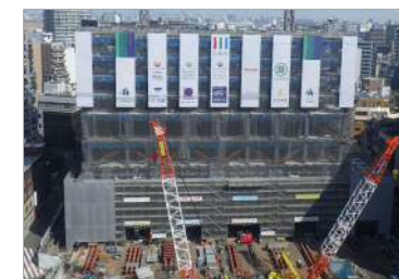
▲建設工事写真
