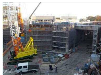
▲ミックスペーパー資源化処理等の建設工事写真
