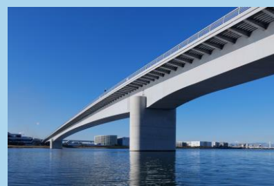
多摩川スカイブリッジ
