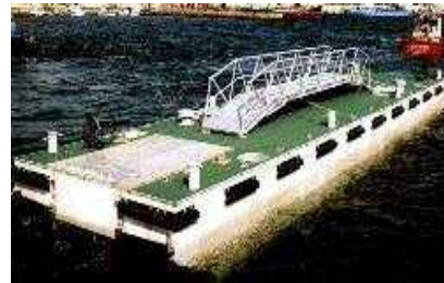
輸送用浮き棧橋
