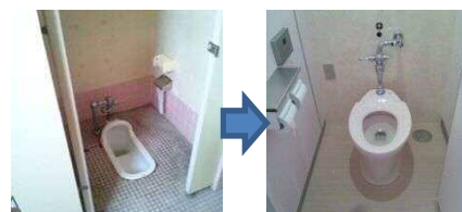
学校のトイレ改修
