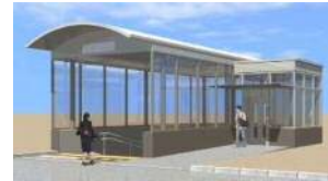
向ヶ丘遊園駅連絡通路
