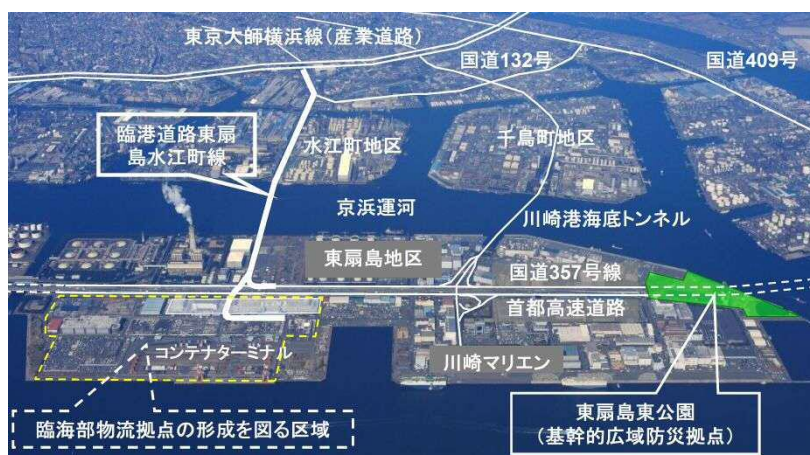
川崎港航空写真
