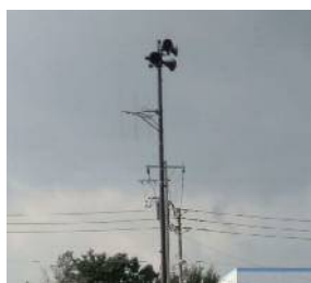
防災行政無線設備
