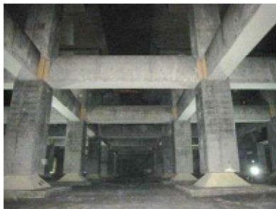
鷺沼配水池 耐震補強
