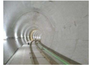
大師河原貯留管の整備
